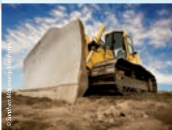
L'Union européenne aide à la construction de nouvelles routes.
