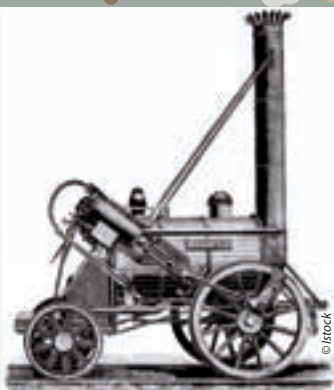
La «Fusée» de Stephenson.
